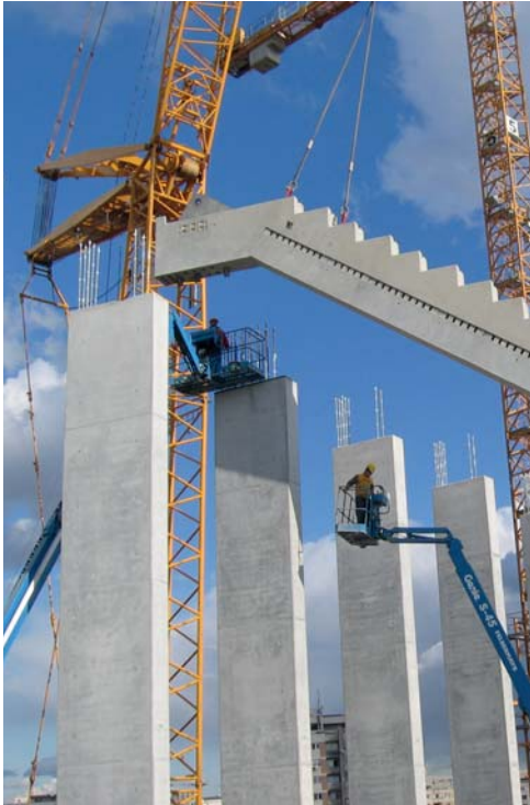
Sicherer Transport von Beton-Fertigteilen
